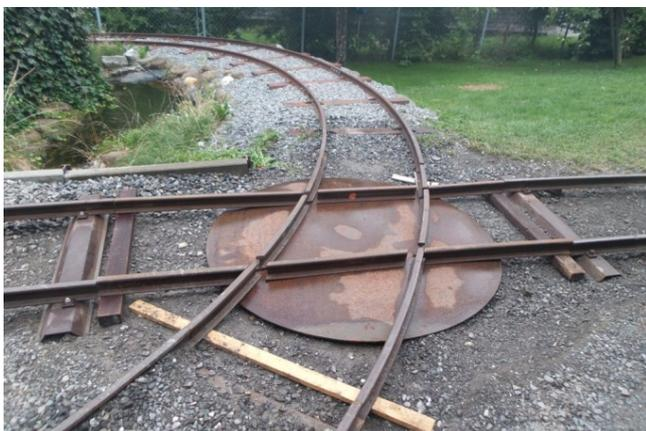
Die Eisenplatte wurde positioniert und die vorgebogenen Anschlussstücke konnten erstmals aufgelegt werden. Ab diesem Zeitpunkt war der große Winkelschleifer das allerwichtigste Werkzeug.
