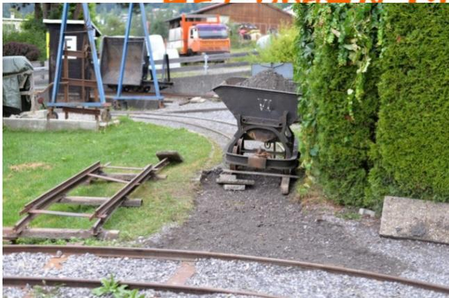
Als Grundplatte fand eine alte Drehscheibe Verwendung, die im Fundus vorhanden war. Zwei Kipploren wurden Schaufel für Schaufel mit Schotter gefüllt. Dieses Baumaterial konnte nach Abschluss der Arbeiten größtenteils wieder verwendet werden.
