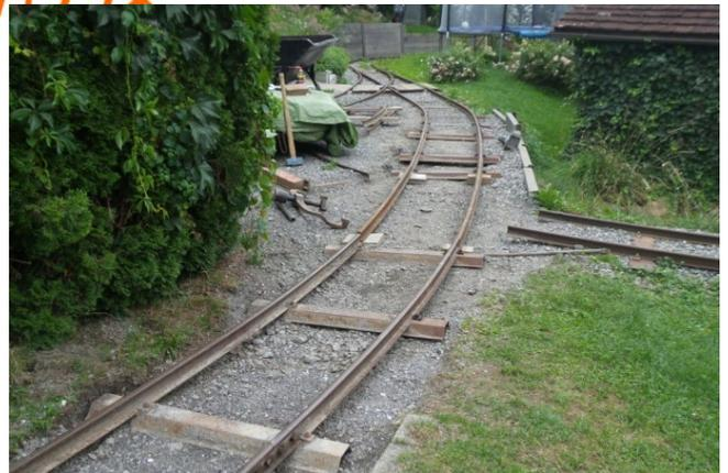
Die Gleise, Radlenker und Zwangsschienen mussten Stück für Stück vermessen, vorgebogen, angepasst, abgeflext und schlussendlich mit dem Schweißgerät angeheftet werden. Die Zwangsschienen erhielten einen langen Vorlauf, um die Achsen behutsam „einzufangen“.
