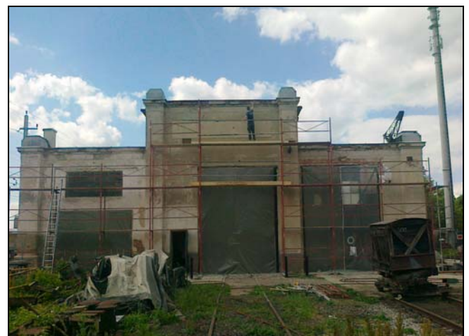
Halle1, Bauabschnitt 7 am 14.05.2013
